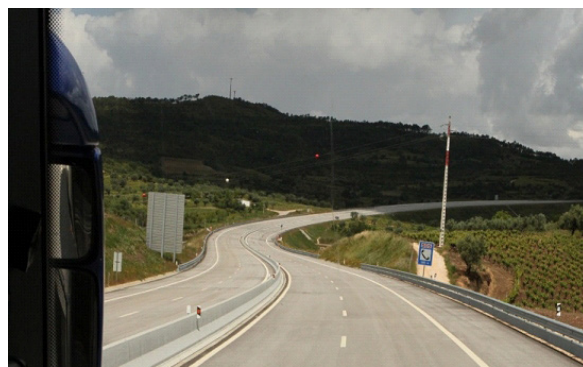
Obr. 1: Dálnice A32 Coimbra – Porto, 2015, foto V. Řezáč
