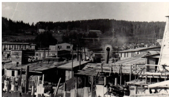
Obr. 1-2: Stavba vodního díla
